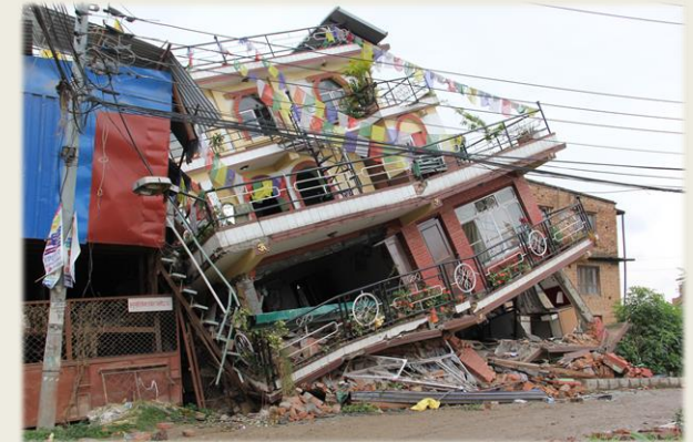
eingestürztes Haus in Kathmandu
